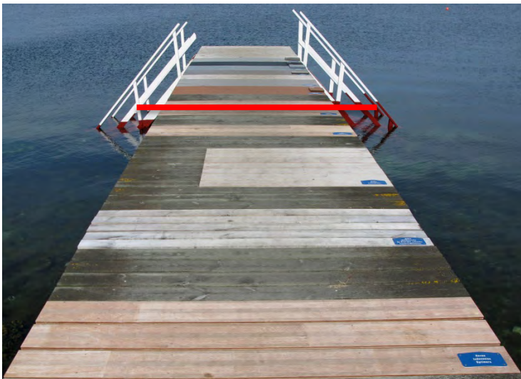
Figur 5. Brygga J, 2014-06-10, kompletterad med trämaterial installerade 2014-03-14 (under det röda strecket).
