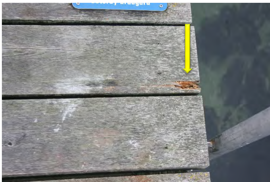
Figur 11. Brunröteangrepp i planka av gotländsk furukärnved behandlad med Sioo. Angreppet har skett i splintved. Förekomst av splintved är inte helt ovanligt i det som marknadsförs som kärnved.
